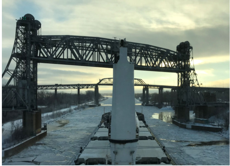
Figure 3. Vue vers l'aval des ponts 7A et 7B de la Voie maritime avec leur travée levée. On voit le pont Honoré-Mercier en arrière-plan (Source : tierce partie, avec permission)
