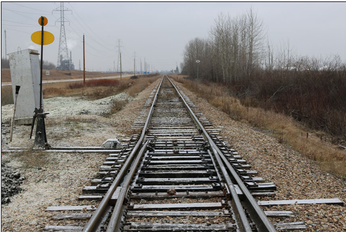
Figure 6. Vue de l'aiguillage ouest du triangle de virage en position renversée (vue vers l'ouest)
