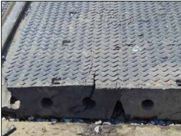
Figure 9. Surface en caoutchouc du passage à niveau de la rue Queen (point milliaire 19,50)
