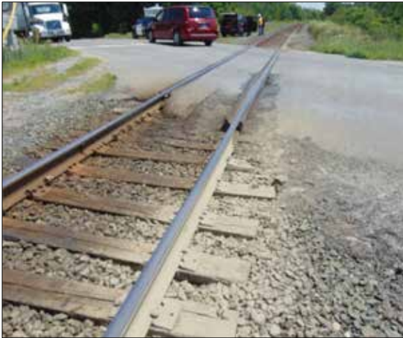
Figure 7. Vue vers l'est de la contamination par de la boue à l'ouest du passage à niveau de la rue Carroll Est
