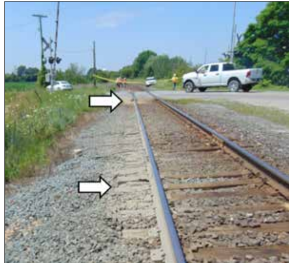
Figure 8. Vue vers l'ouest de la contamination par de la boue à l'est du passage à niveau de la rue Carroll Est
