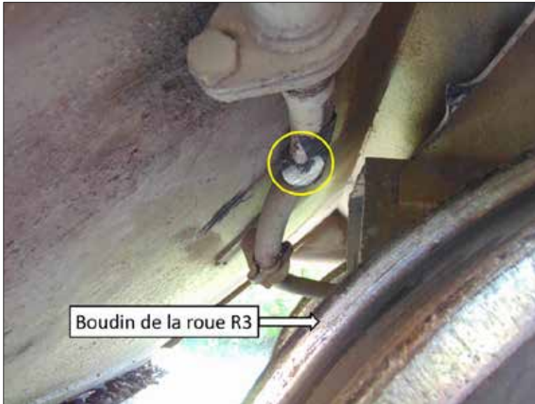
Figure 4. Marques de brûlure/meulage sur la conduite générale (encerclée) par suite du contact avec le boudin de la roue R3 (flèche) du wagon NAHX 35909
