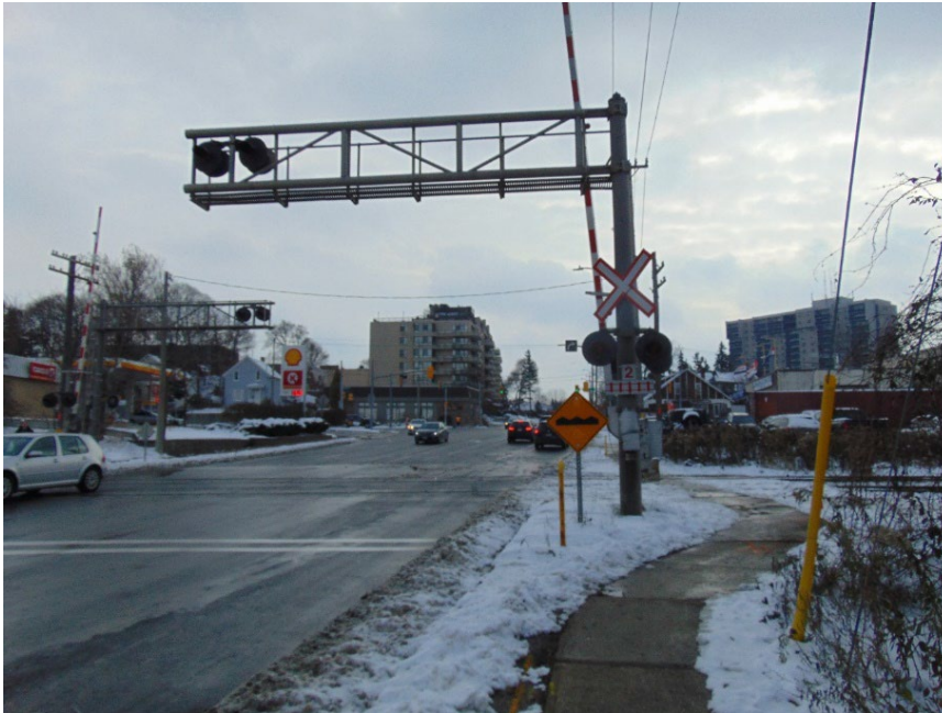
Figure 7. Passage à niveau de la rue Lancaster Ouest, vue vers le sud (Source : BST)
