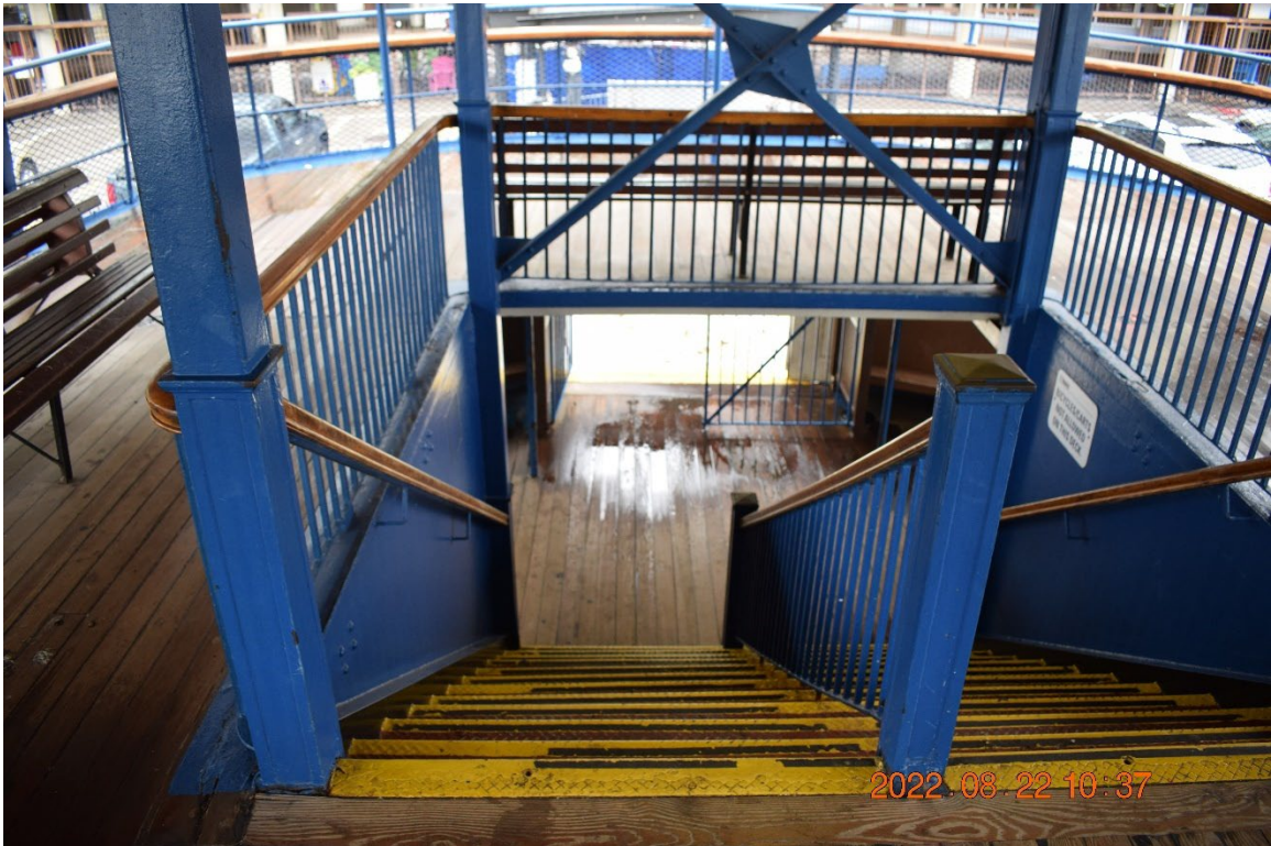
Figure 3. Escalier descendant du pont promenade au pont principal (Source : BST)
