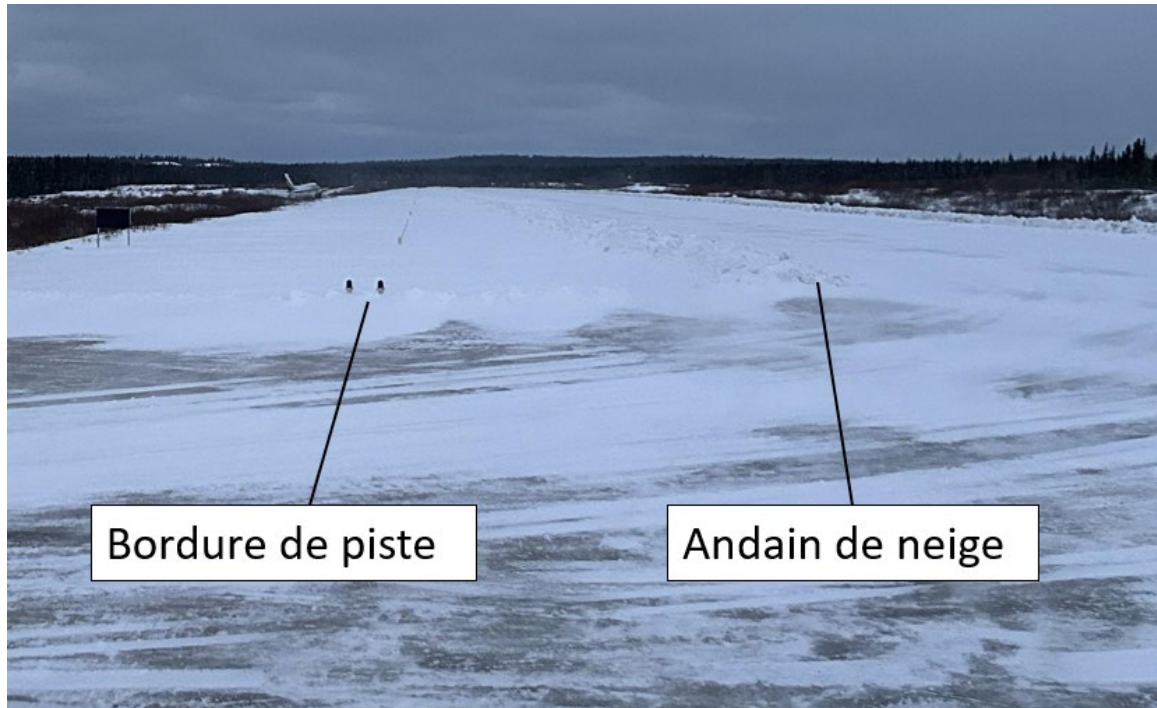
Figure 1. Andain de neige présent sur le côté gauche de la piste 28 à l'aéroport de Wemindji (Source : Propair, avec annotations du BST)
