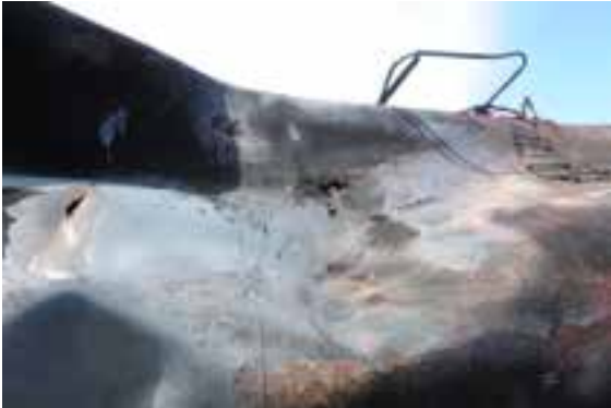
(e) Gros plan d'une perforation et d'un trou de brûlure dans la coque
