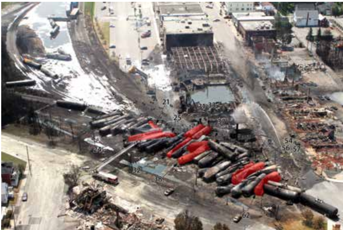
Figure 8: Photographie aérienne de wagons (en rouge) avec brèches aux DDP résultant de dommages attribuables aux chocs
