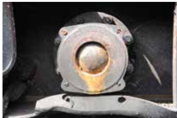
(h) Gros plan de la bille fermée du RDB
