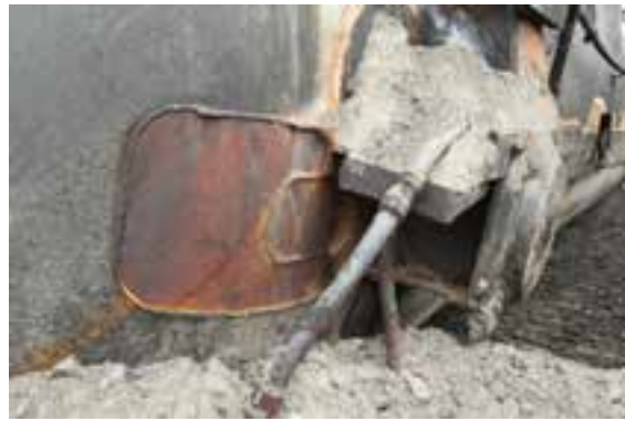
(b) Gros plan de la longrine tronquée rompue au bout B
