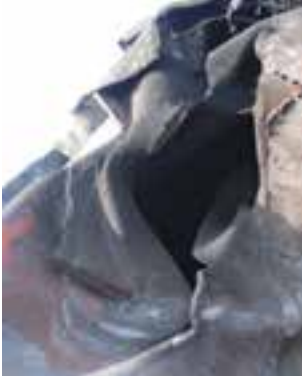
(c) Gros plan de la rupture à la soudure joignant la coque à la tête du bout B
