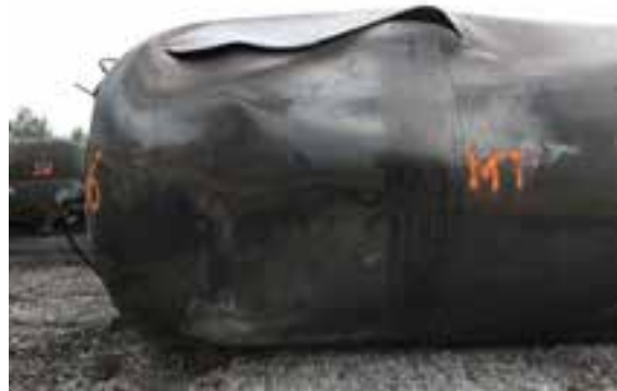
(f) Rupture thermique dans la coque
