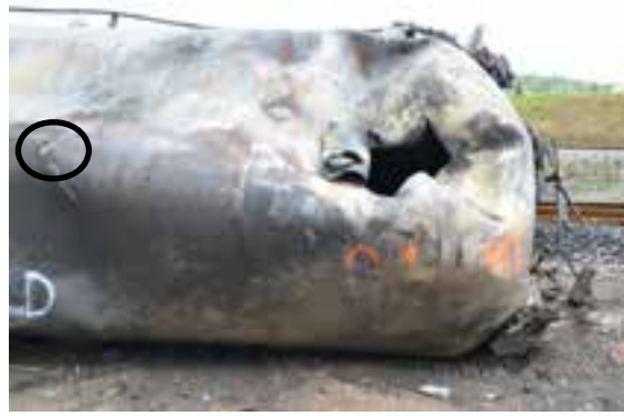
(b) Détail de la perforation près de la tête du bout B et de la petite déchirure à la soudure (encerclée) (photo du Projet de sécurité RSI-AAR)
