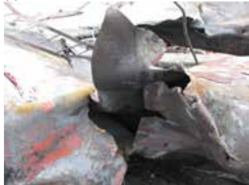
(f) Rupture de la coque adjacente au trou d'homme
