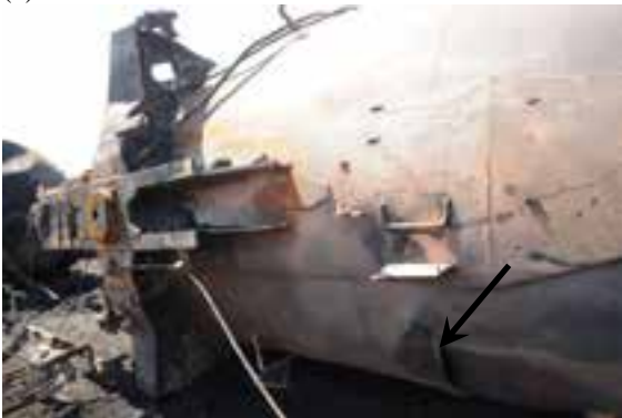
(e) Rupture dans la coque (flèche)
