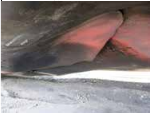
(e) Rupture de la coque dans la région indiquée par la flèche en (d)
