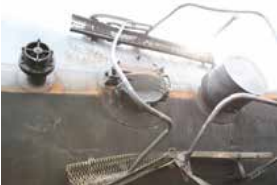
(e) DDP, raccords supérieurs et trou d'homme
