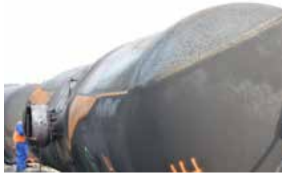
(d) Vue en angle de bombements sur le côté droit de la citerne (photo du Projet de sécurité ferroviaire RSI-AAR)
