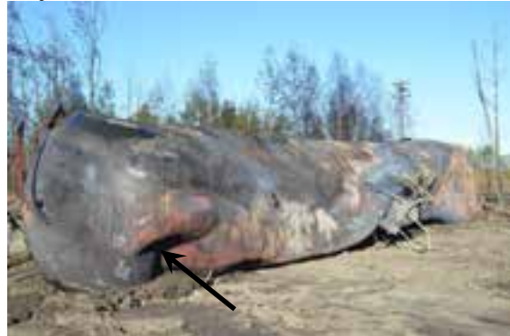
(d) Perforation au fond d'une bosselure profonde (photo du Projet de sécurité RSI-AAR)
