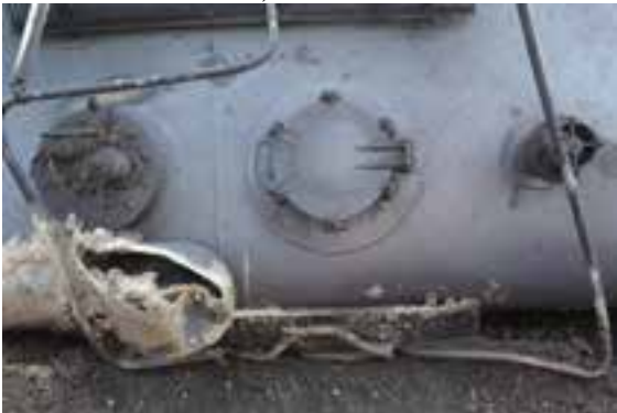
(e) Raccords supérieurs, trou d'homme et DDP
