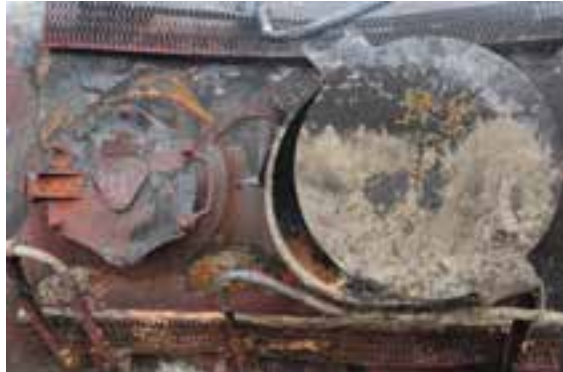
(d) Trou d'homme et raccords supérieurs
