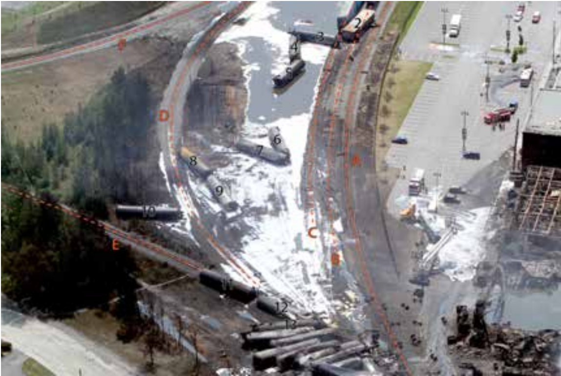
Figure B-1: Vue aérienne de la zone du déraillement montrant la position des wagons-citernes déraillés à partir du wagon couvert (n° 2 dans le convoi (dlc)) jusqu'au wagon-citerne NATX 310457 (n° 13 dlc)
