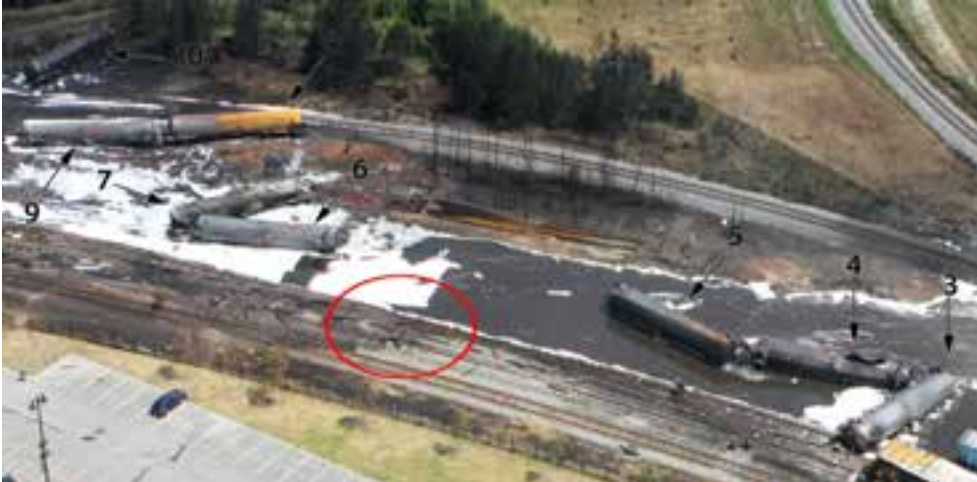
(a) Vue aérienne vers le nord montrant les wagons n os 3 à 10 dlc. Les tronçons brisés des voies de triage 1 et 2 sont encerclés.
