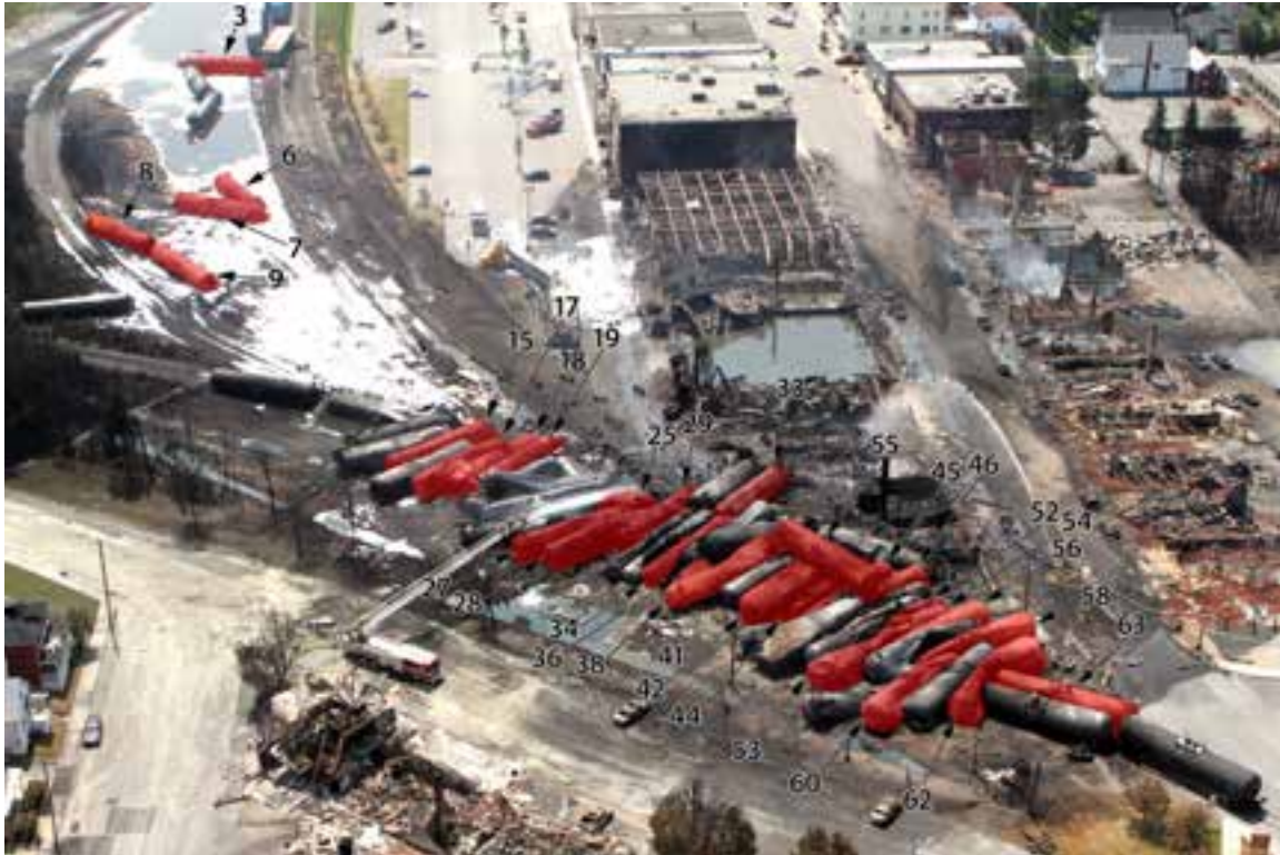
Figure 6: Photographie aérienne de wagons (en rouge) avec brèches de tête résultant de dommages attribuables aux chocs
