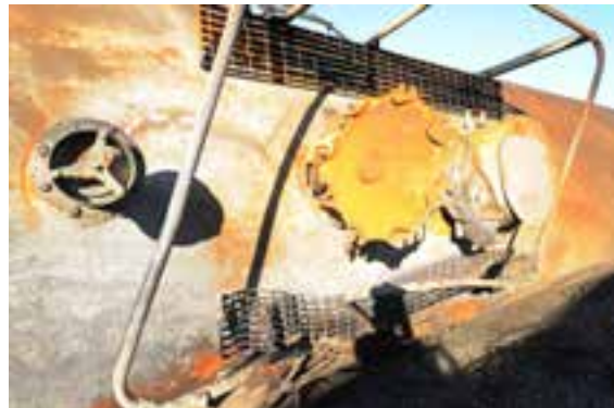
(f) DDP, trou d'homme et raccords supérieurs
