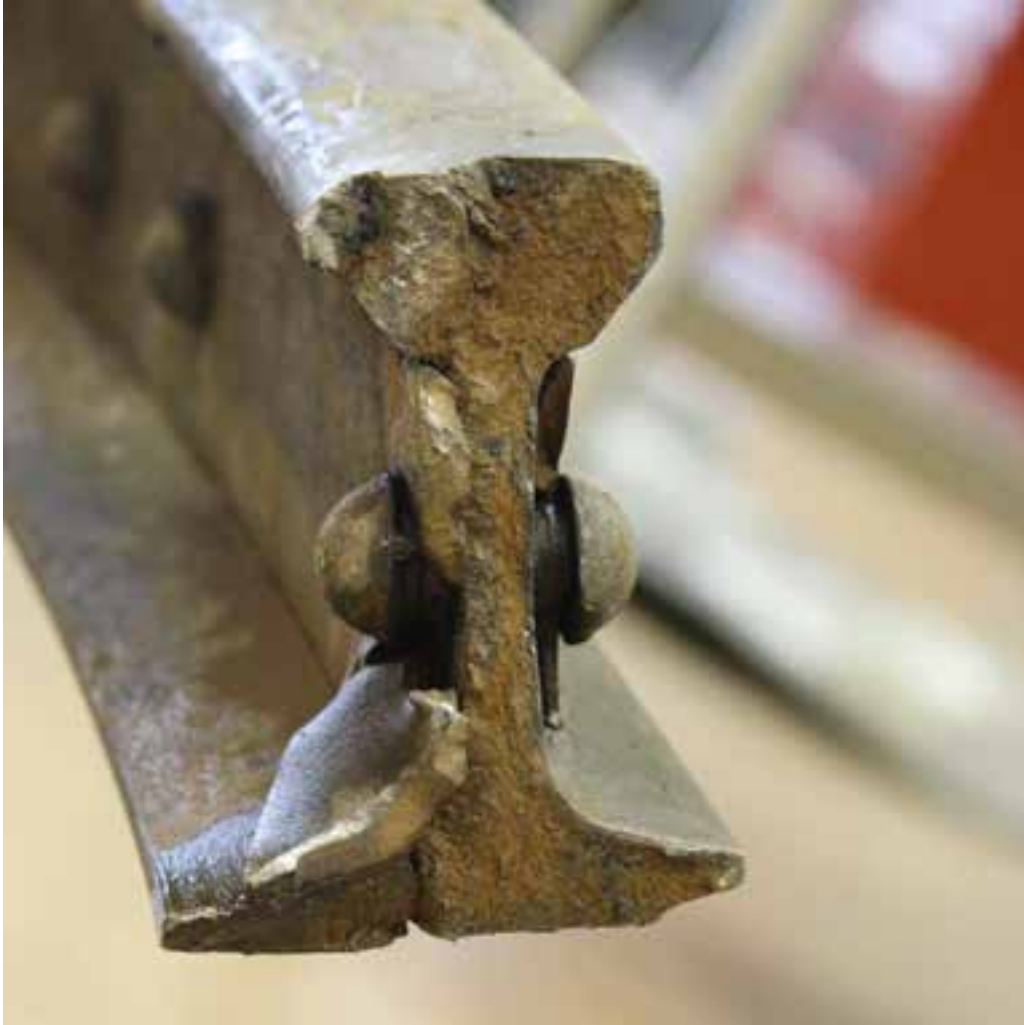
Figure 12 : Surface de rupture de la lame d'aiguille gauche de 22 pieds (point C dans la Figure 8)
