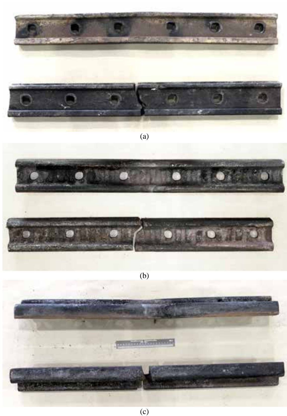
Figure 16 : Diverses vues des éclisses démontées
