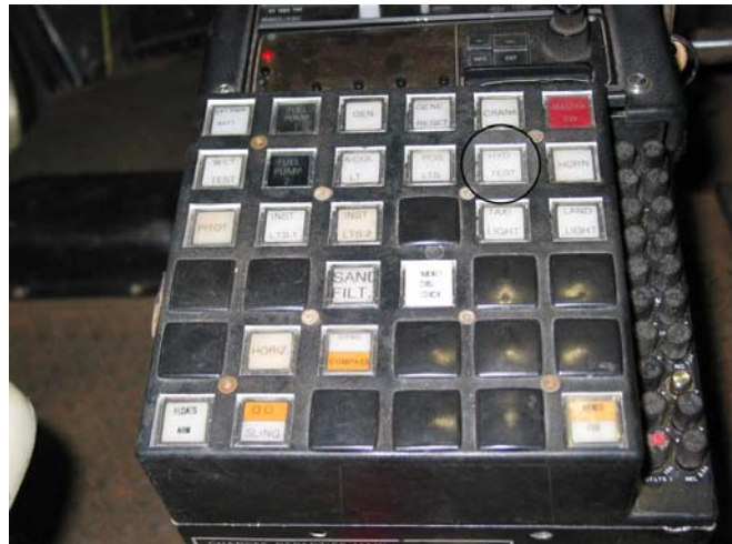
Photo 3. Bouton de test hydraulique (HYD TEST)
