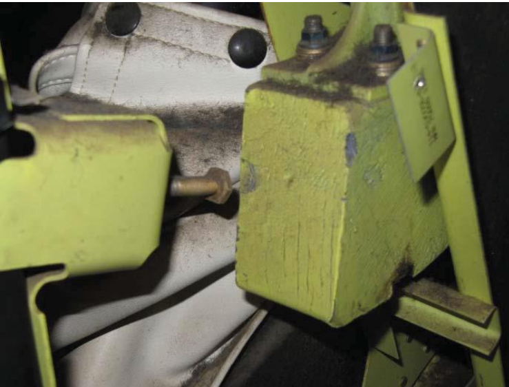
Figure 2 Contact partiel remarqué sur le contrepoids, devant le boulon de butée
