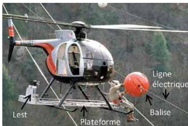
Photo 1. Installation d'une balise sphérique (Source : P&R TECH, avec annotations du BST)
