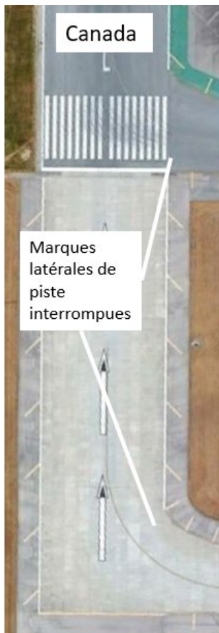
Figure 8. Marques latérales de piste à l'aéroport international de Vancouver (Source : Google Earth, avec annotations du BST)
