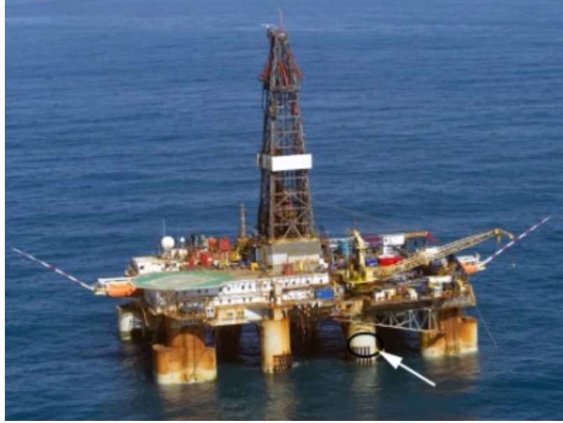
Photo 5. Emplacement des dommages de l'appareil de forage GSF Grand Banks (source : Provincial Aerospace Limited)
