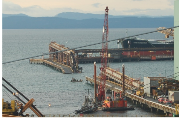
Photo 4. Pont sur chevalets vu du poste à quai n° 2
