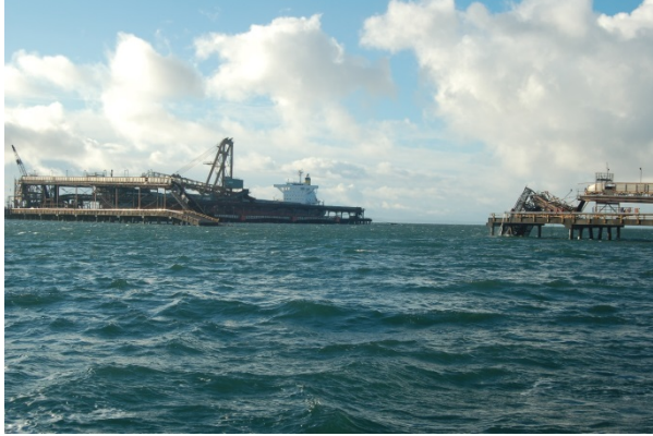
Photo 3. Pont sur chevalets vu du bassin en regardant vers le poste à quai n° 1
