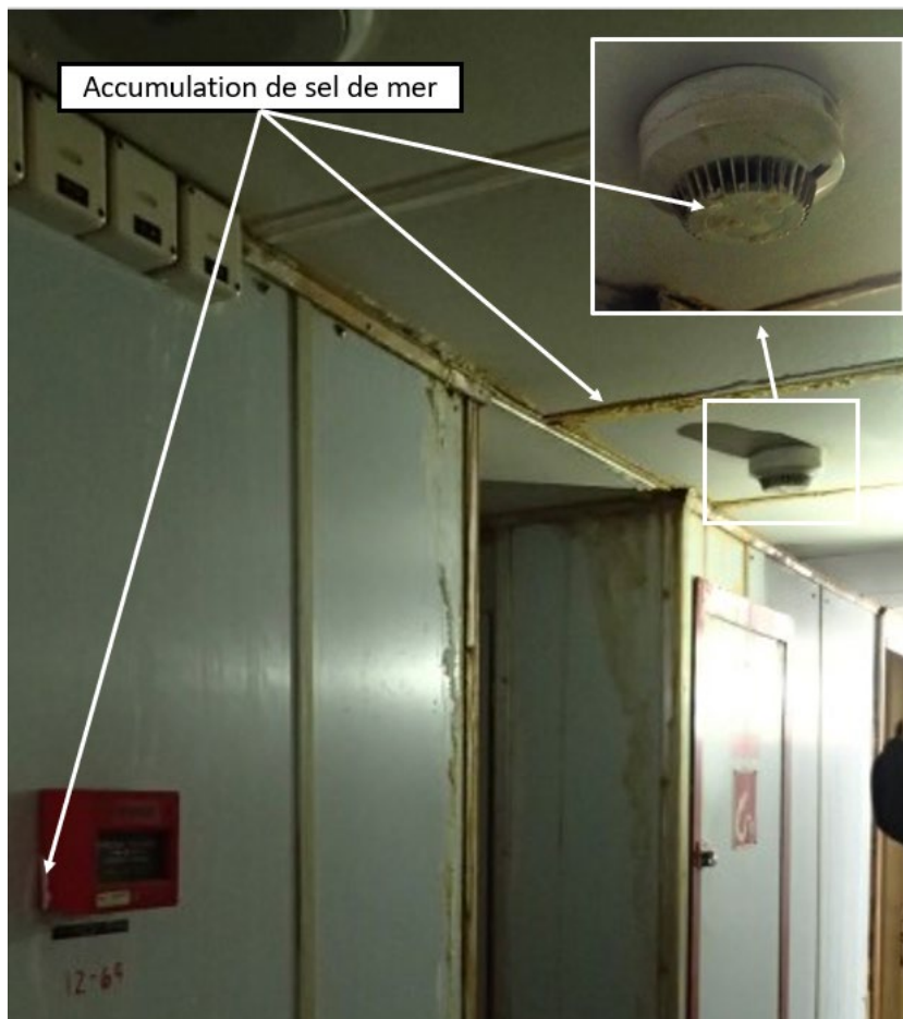
Figure G9. Détecteur endommagé (Source : BST)
