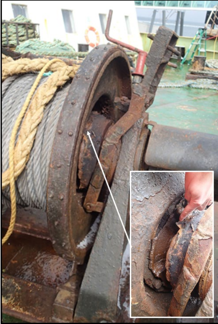
Figure G30. Engrenage du treuil d'amarrage tribord (Source : BST)
