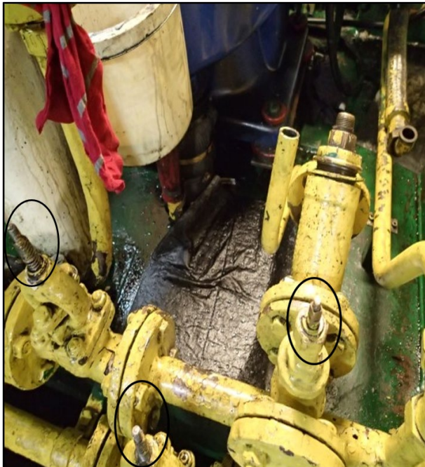
Figure G17. Soupapes d'isolement sans volant (Source : BST)
