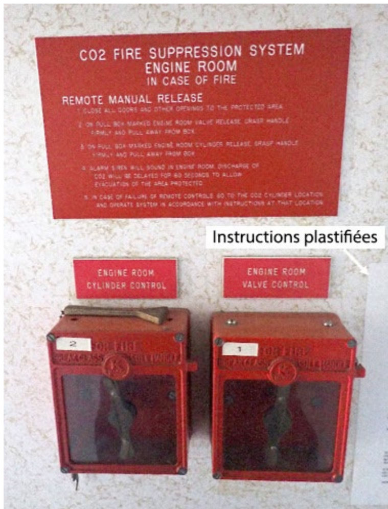
Figure 13. Poste de libération à distance de CO 2 sur le pont C du Tecumseh (Source : BST)
