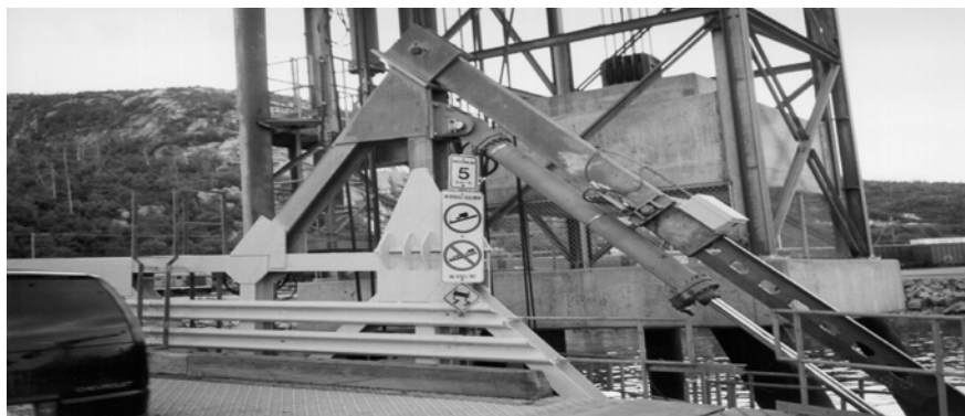
Vue des panneaux de signalisation placés l'entre-sortie de l'embarcadere-dbarcadre Baie-Comeau (Québec). Le panneau supérieur indique la limite de vitesse pour les véhicules qui circulent sur la rampe.
