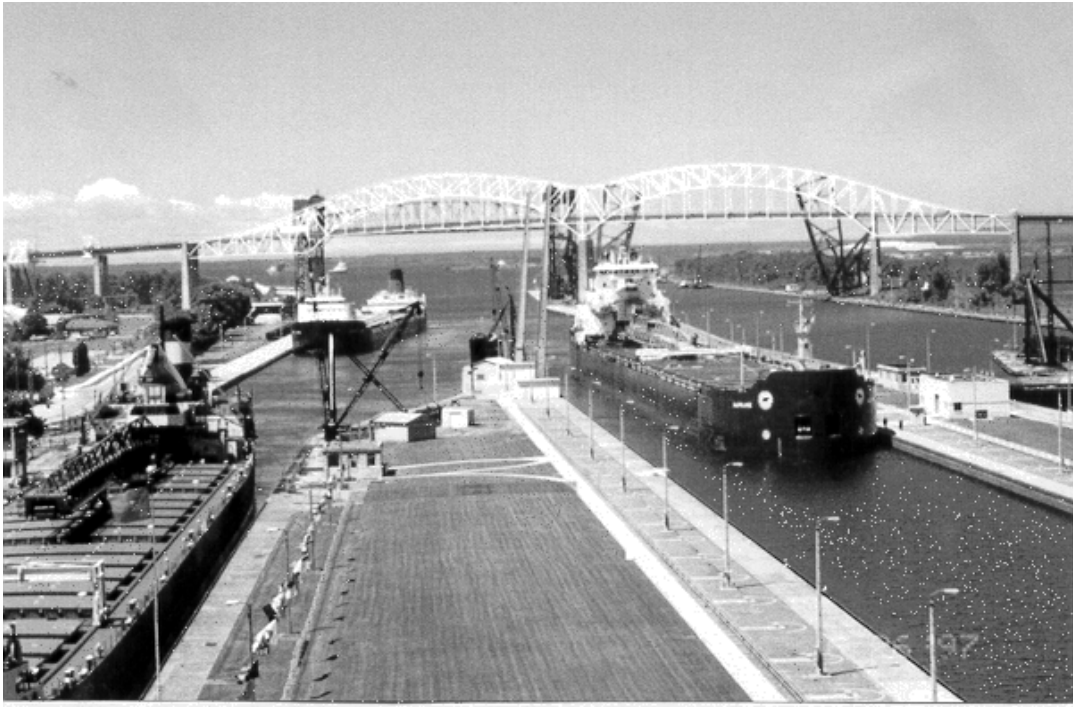
CLUSES DU CANAL DES CHUTES DE LA ST. MARYS - EN DIRECTION OUEST
