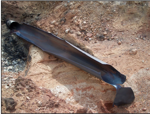
Photo 4. Section rompue du gazoduc de Nig Creek de Westcoast
