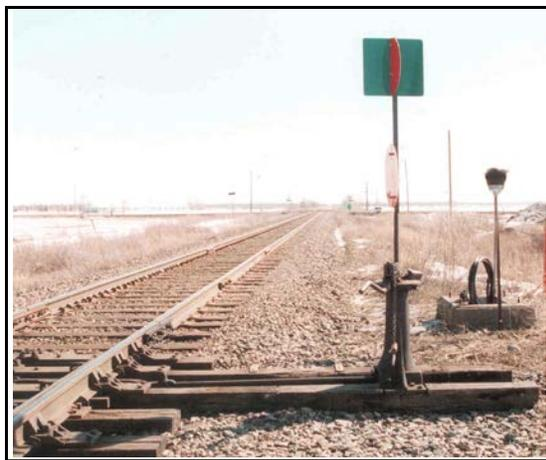
**Figure 17** - Les photographies du haut montrent que les pointes d'aiguille sont ouvertes de 3/16 de pouce, mais que le signal de CCC montre quand même un feu vert. Les photographies du bas montrent un levier de manœuvre d'aiguillage déverrouillé et partiellement relevé, alors que la cible d'aiguillage est quand même au vert.
