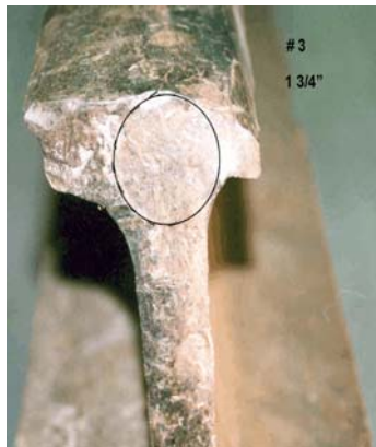
Photo 2. Fissure de fatigue transversale
