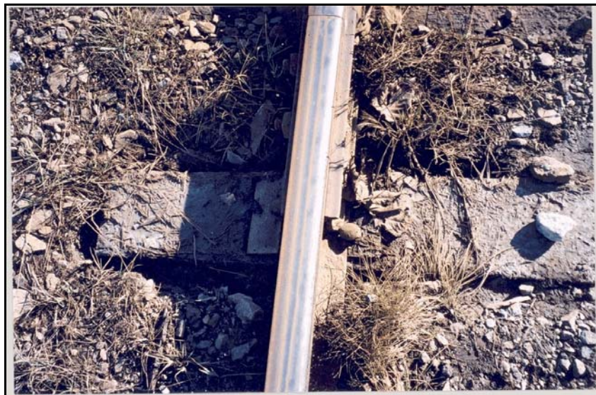
Photo 3. Ballast pollué de la voie G-5, près de l'endroit où le déraillement a eu lieu
