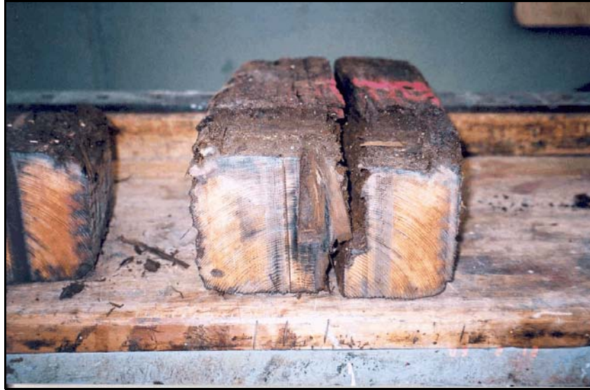
Photo 2. Défautes des traverses de la voie G-5
