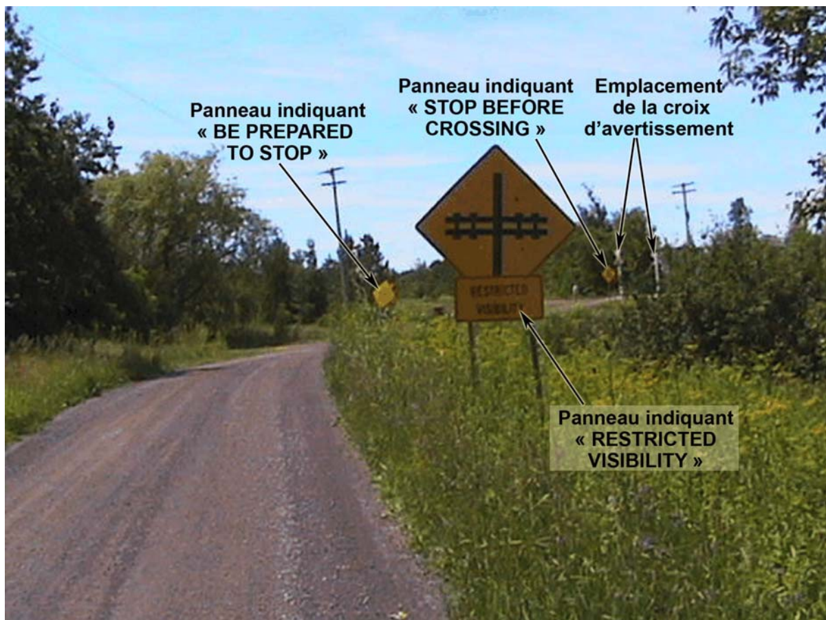
Photo 2. Signaux du plan de signalisation 2 installés aux abords du passage à niveau croisant la route à un angle aigu
