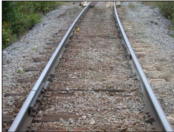
Photo 3. Positions des joints de rail vus du Sud
