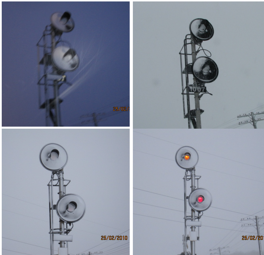
Photo 2. Haut - Neige sur la lentille du signal d'entrée 1007 (25 février 2010 à 7 h et à 11 h 30) Bas - Signal avancé 971 avant et après le nettoyage des lentilles (Source : BST et CN)
