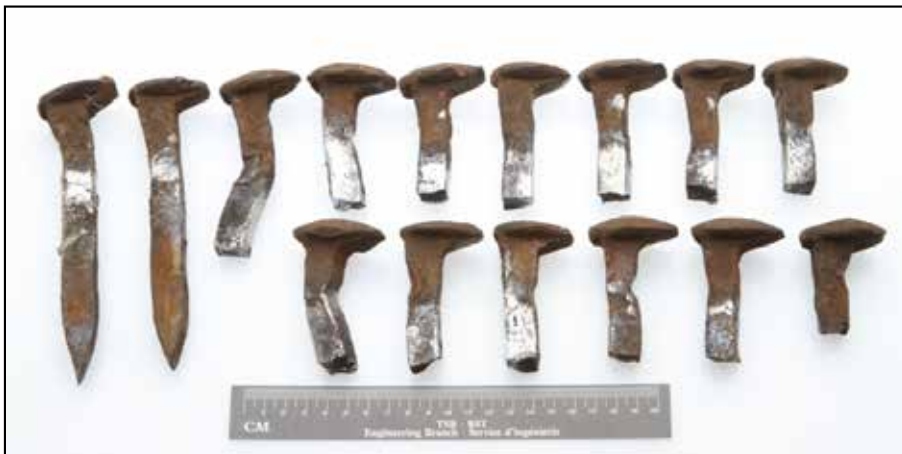
Photo 14. Crampons brisés de la voie 21
