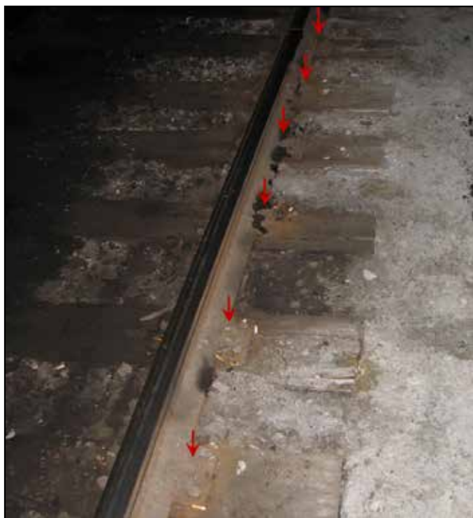
Photo 6. Les flèches rouges indiquent l'emplacement des selles de rail de 10 pouces fixées par des crampons à section arrondie à la fin de la courbe – rail nord
