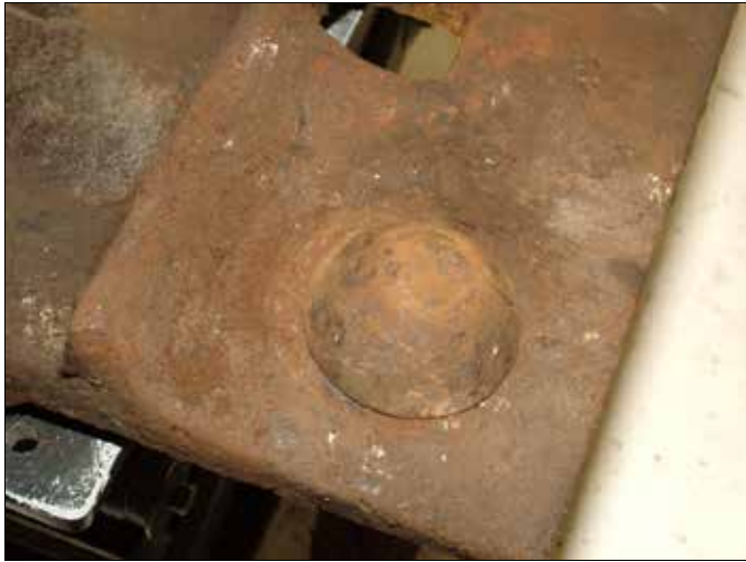
Photo 13. Vue du dessus de la tête d'un crampon à section arrondie dans une selle de rail de 10 pouces
