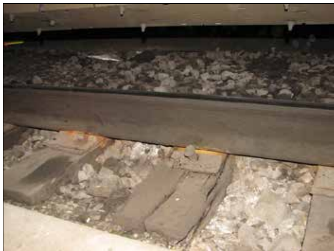
Photo 7. Traverses, selles de rail, crampons et ballast
