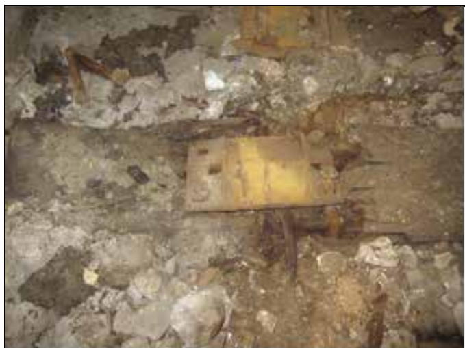
Photo 8. Traverse, selle de rail, crampons et ballast en gros plan
