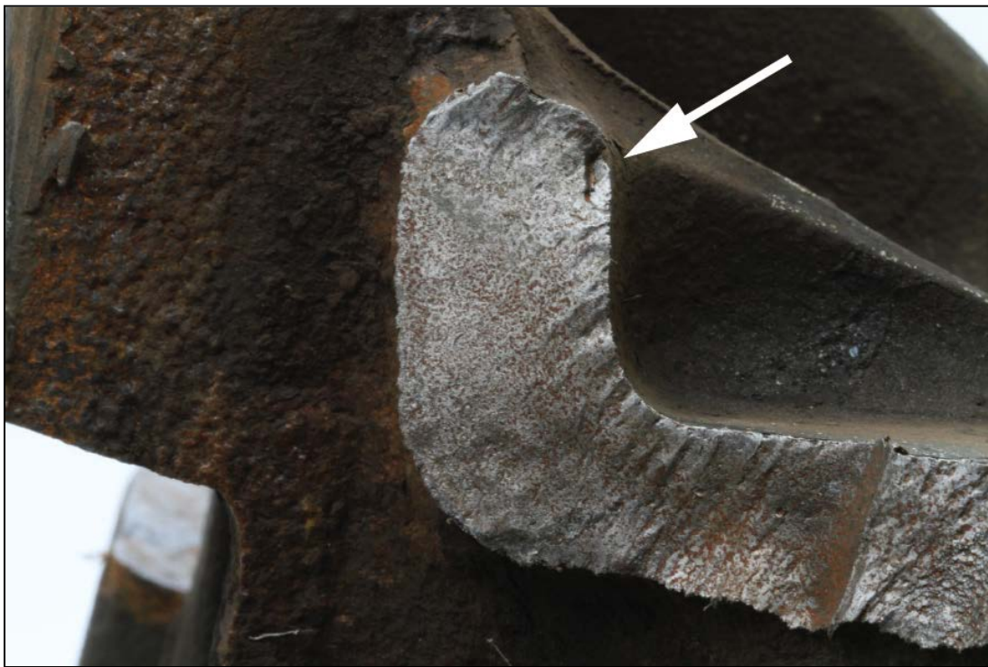
Photo 3. Gros plan du point d'origine après nettoyage. (Note : l'irrégularité de la surface de moulage est visible près du coin supérieur droit de la surface fracturée.)
