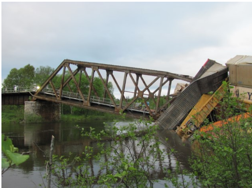
Photo 1. Effondrement de l'extrémité sud du pont ferroviaire
