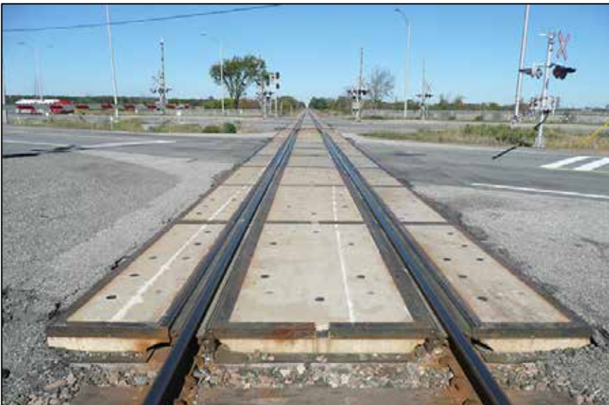
Photo 7. Vue vers l'est à partir de l'extrémité ouest du passage à niveau. Des marques de boudin des roues du train étaient évidentes depuis le milieu du passage à niveau en direction ouest
