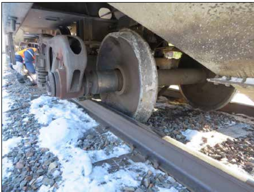
Photo 1. Essieu déraillé du wagon CRDX 15109
