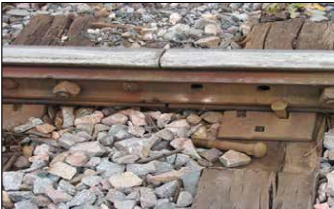
Photo 6. Boulons manquants
