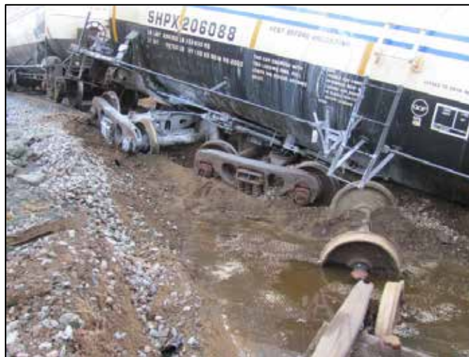
Photo 3. Wagons déraillés et appareils partiellement submergés
