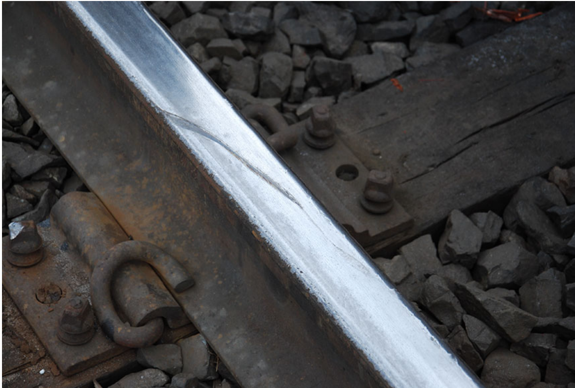
Figure 3. Marque de boudin laissée par le train sur le rail (point milliaire 0,40, subdivision de Red Deer)
