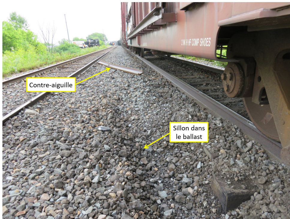
Figure 6. Contre-aiguille près d'un sillon dans le ballast (Source : BST)
