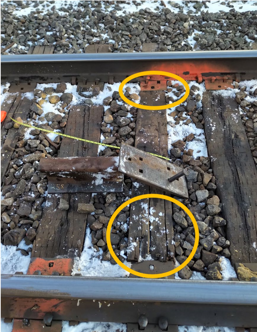
Figure 5. Traverse à l'extrémité ouest du rail de rechange montrant des fissures sur toute la longueur de la traverse et la décomposition du bois sous la selle de rail (Source : BST)
