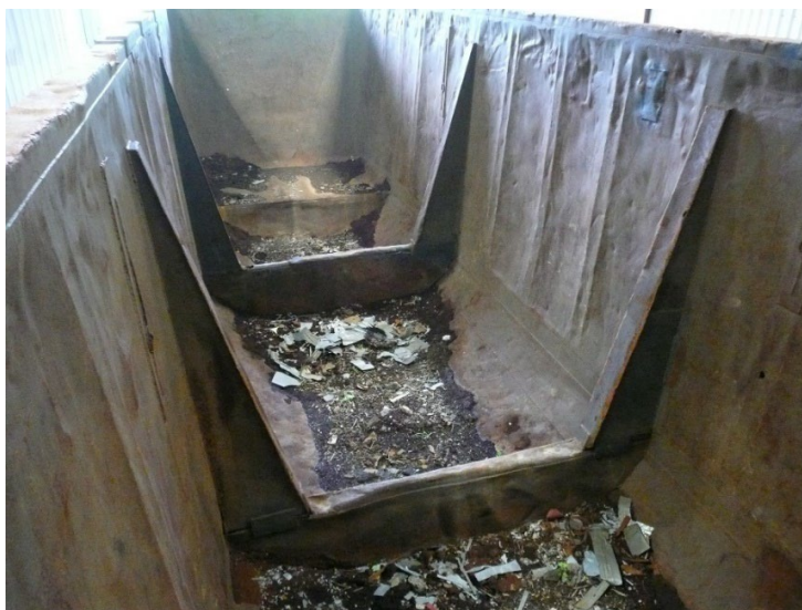
Figure 24. Wagon DJJX 30156, tel qu'il a été modifié, comportant 2 grands profilés en U en acier mécanosoudés à l'intérieur du wagon pour compenser le retrait des 2 barres transversales supérieures de renfort (source BST)
