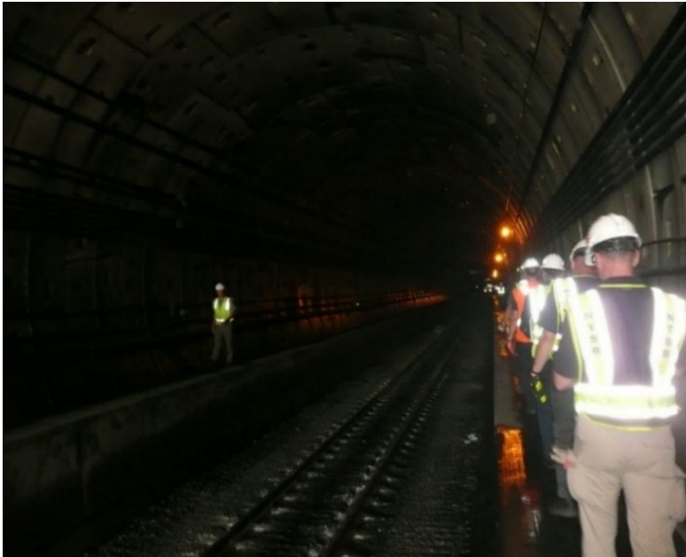
Figure 5. Entrée du tunnel du côté américain (Source : BST)
