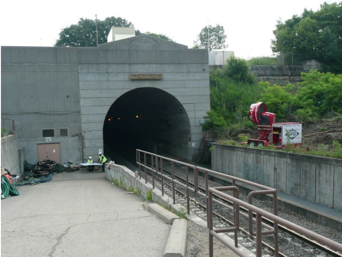
Figure 2. Portail du tunnel à Port Huron aux États-Unis (Source : BST)
