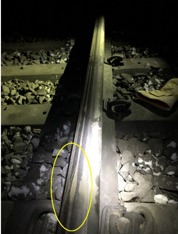
Figure 5. Marque de boudin de roue (encerclée) indiquant qu'une roue avait passé par-dessus le rail extérieur (Source : Canadien Pacifique, avec annotations du BST)
