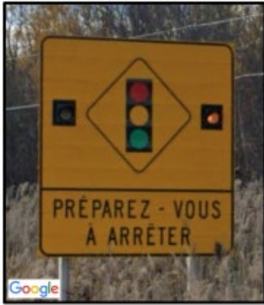
Figure 4. Panneau de signalisation avancée installé sur la route 116 (Source : Google Maps)
